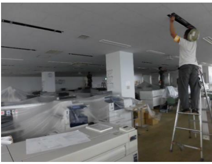
LED照明への切り替え
