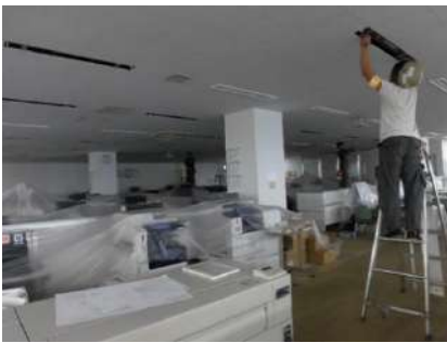
LED照明への切り替え
