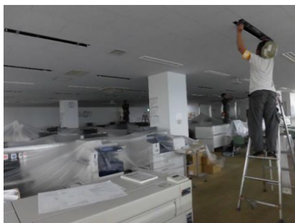
LED照明への切り替え
